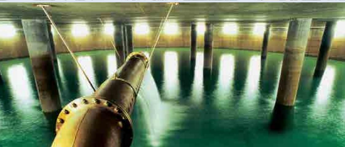
Die 4 Trinkwasserbehälter des Wasserverbandes Aabach-Talsperre an den Standorten Aufbereitungsanlage, Hemmern und Steinhausen dienen der Erhöhung der Versorgungssicherheit und dem Ausgleich der Verbrauchsschwankungen. Sie umfassen eine Speicherkapazität von 33.000 Kubikmetern. Das aufbereitete Trinkwasser wird zunächst in zwei Erdhochbehältern mit einem
