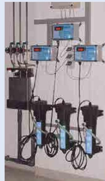
*Feinsttrübungsmesseinrichtung im Ablauf der 1. Filterstufe*
