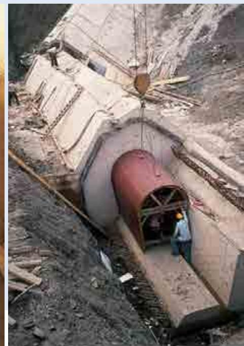
Der Kontrollstollen am wasserseitigen Dammfuß stellt die Verbindung zwischen Dammdichtung und Untergrund dar. Er dient heute im Wesentlichen der Kontrolle von Dammbewegung, Setzungsverhalten und Sickerströmungen.
