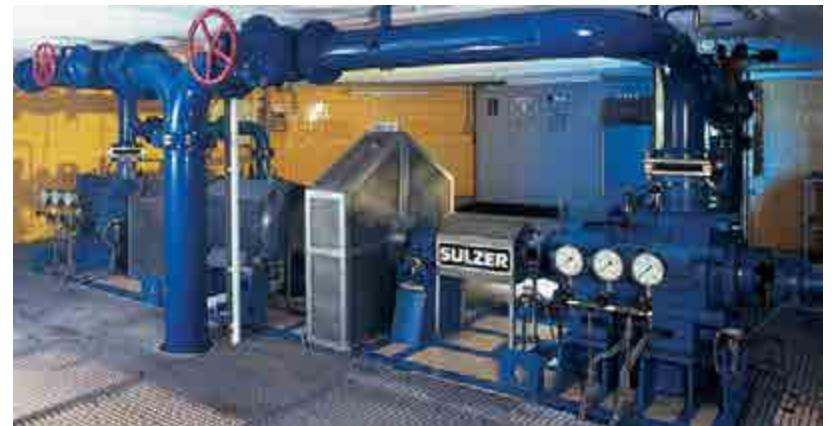
Mitte 1990 werden im Zulauf zum Behälter Steinhausen zwei mehrstufige Turbomaschinen in Betrieb genommen, die als Turbinen in Verbindung mit einem Drehstrom-Asynchron-Generator rd. 1,5 Mio. kWh/a in das 10 kV-Mittelspannungsnetz der damaligen VEW einspeisen.
